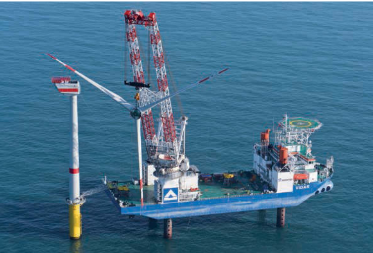
Der Ausbau der Offshore-Windenergie eröffnet für viele Unternehmen neue Chancen. Im Bild: Das 2013 für Hochtief in Dienst gestellte Errichterschiff „Vidar“ installiert eine Windkraftanlage im Offshore-Windpark „Global Tech 1“ in der Nordsee.
