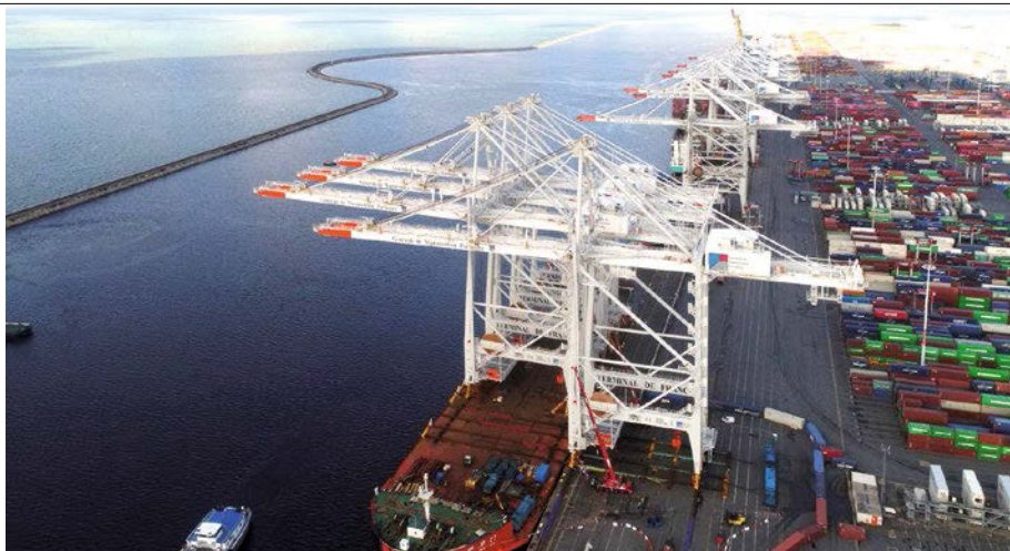
Der Containerterminal von Le Havre soll künftig 24 000 TEU-Containerschiffe abfertigen können
